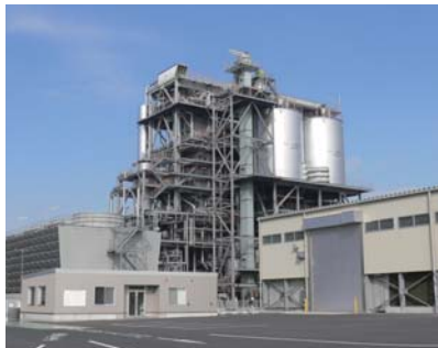
川崎バイオマス発電所
